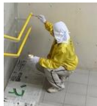
階段の手すりのペンキ塗り
