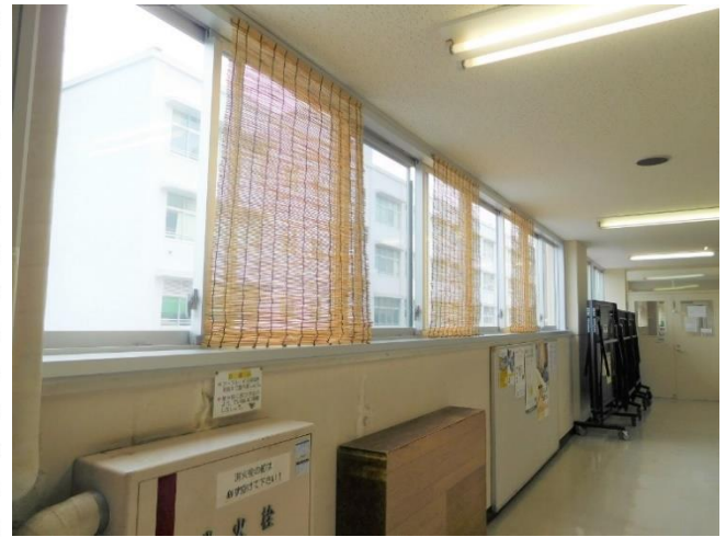
廊下の窓、夏は西日が厳しく差し込みます
