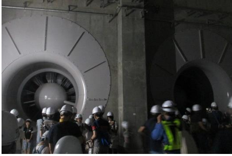
地下にある巨大な換気ファン。
